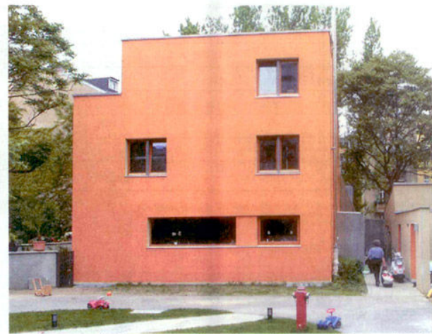
Der Rundweg im Vorhof der Baugruppe in der Kreuzbergstraße ist eine prima Rennstrecke für die Kleinen und dient zugleich als Feuerwehrzufahrt für die Reihenhäuser. Bild: siegl und albert
