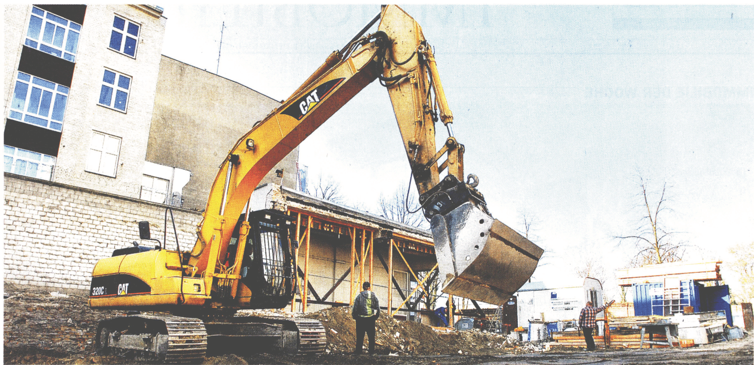
Der Eindruck täuscht. Zwar ist was los an der Möckernstraße – aber nichts, was sich die Baugruppe gewünscht hätte. Hinten sieht man die Sicherungsmaßnahmen an der Durchfahrt zum Nachbarhaus.
